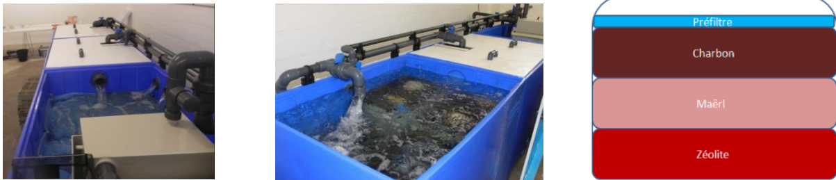
Figure 3: Viviers de stockage des échantillons à terre (gauche et milieu), Schéma des filtres du vivier à terre (droite) (Port de Keroman, 2016, Aglia)
