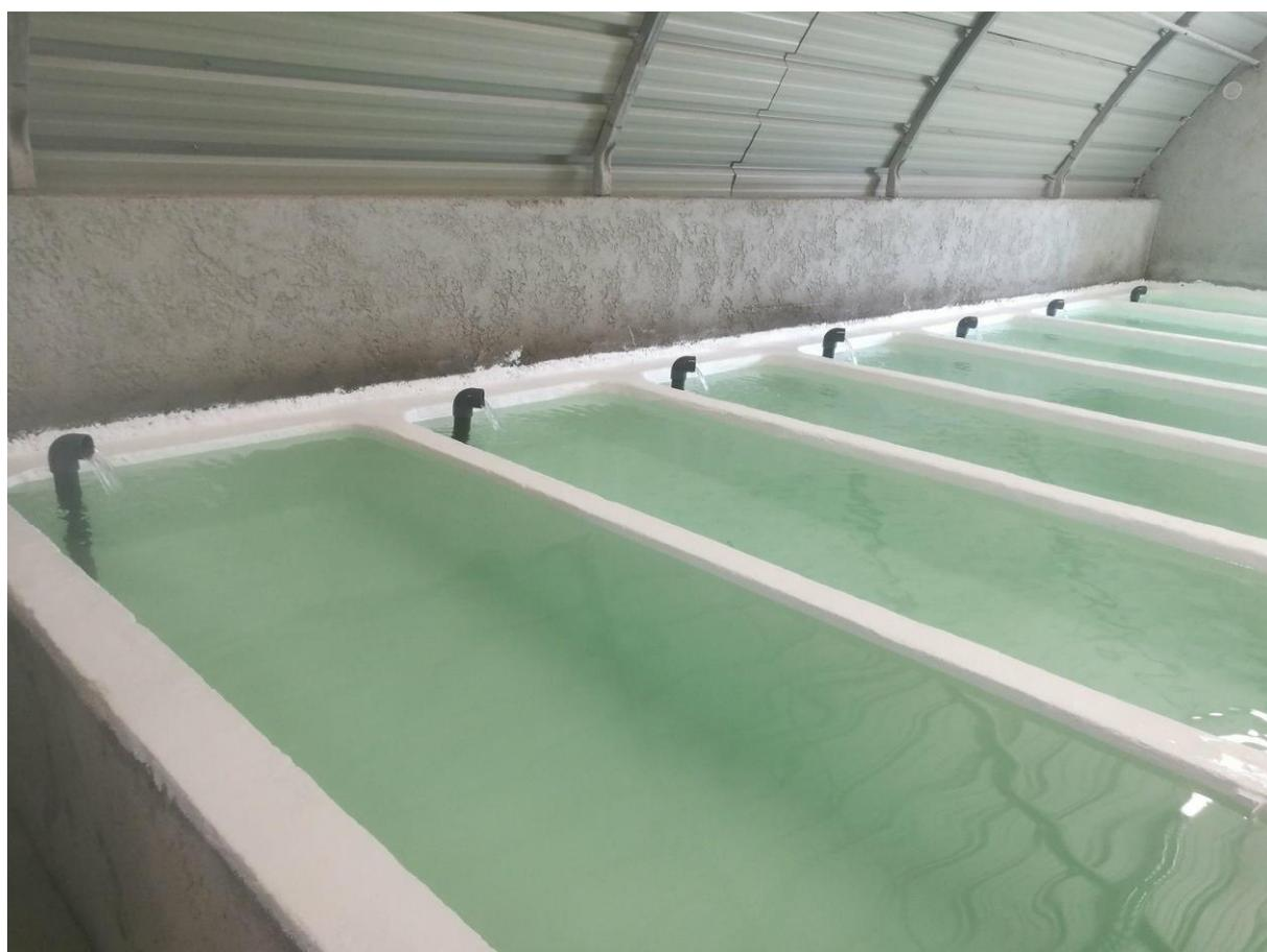
*Raceways A en eau avec peinture imperméable « Impermax aqua ».*
