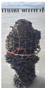
Figure 11 : Pieux en mer avec présence d'un écarteur (anneau rouge)
