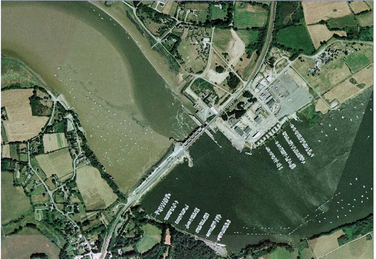
Photo 1.- Vue aérienne du barrage d'Arzal.
