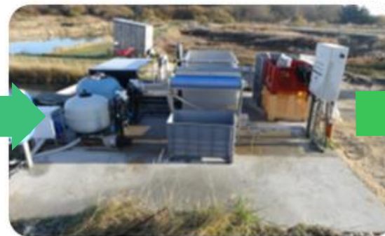
Plateforme de lavage
